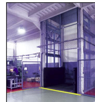
monte-charge à double colonnes avec cage et porte d'accès
