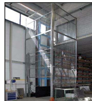
monte-charge à simple colonne avec cage et porte d'accès
